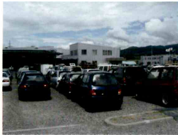
リサイクルセンター外観
